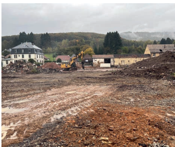
Démolition des bâtiments
